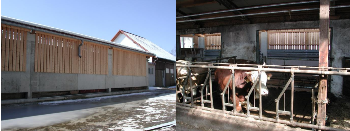
Abbildung 6: Vollspaltenbuchten können durch einen Anbau gut zu einer Zweiflächenbucht mit Tretmistliegefläche erweitert werden.
