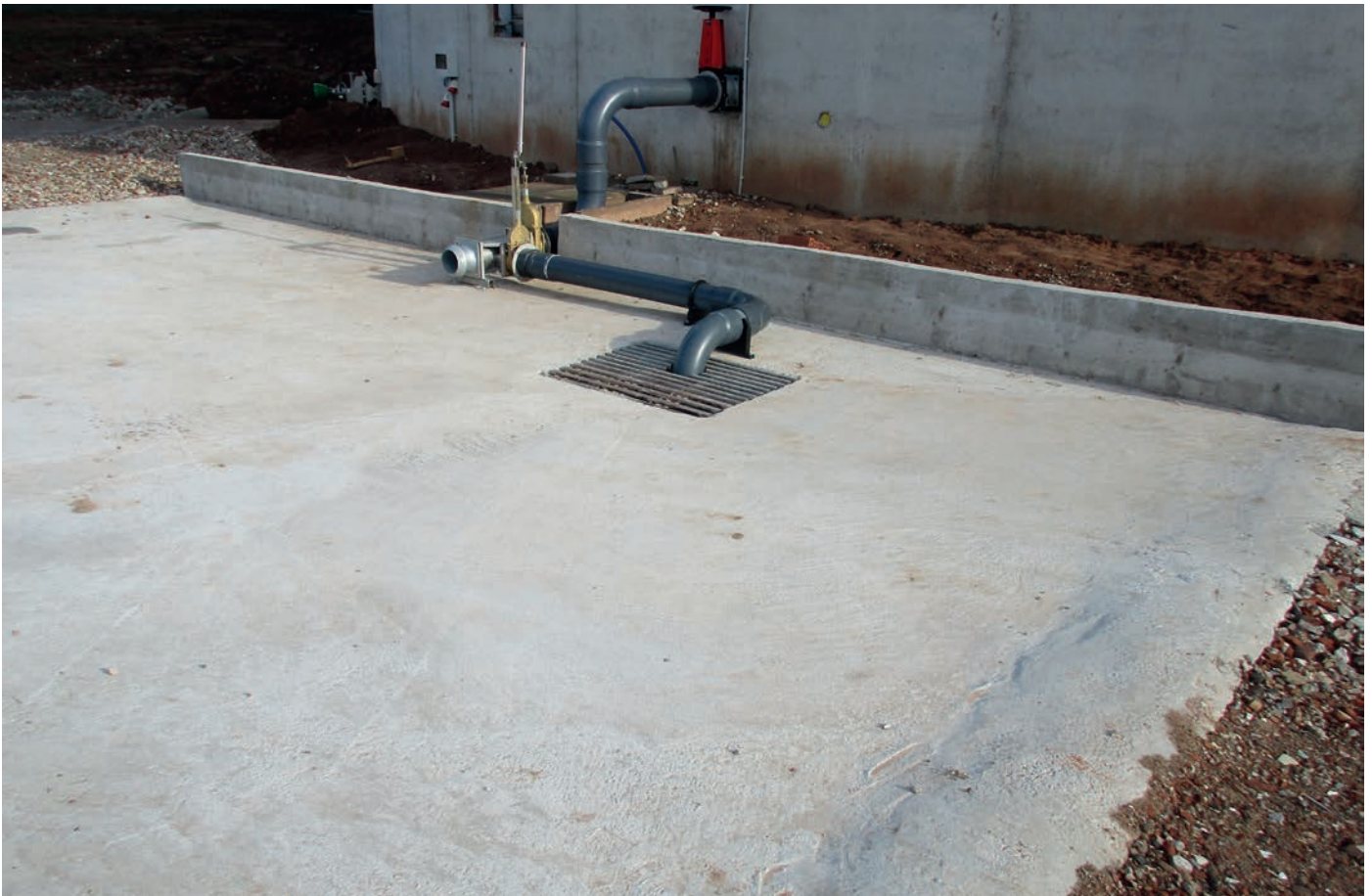
Bild 2 Abfüllplätze für Silagesickersaft müssen befestigt sein und eine ausreichende Größe aufweisen, damit austretende Flüssigkeiten sicher aufgefangen werden. (Quelle: LAZBW, H. Nußbaum).
